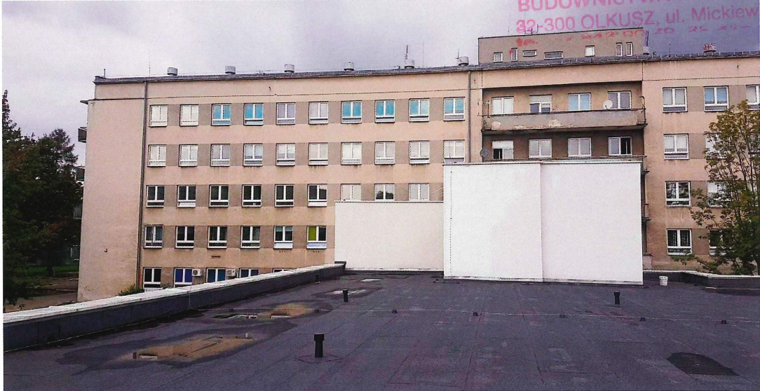
Fot. 7. Widok z dachu SOR na ścianę szybu dźwigowego i klatki schodowej
