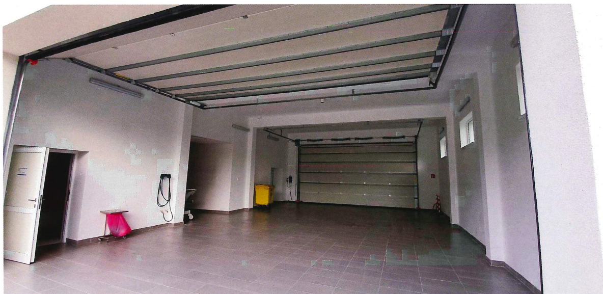
Fot. 5. Wnętrze pomieszczenia podjazdu dla karetek zamykanego bramami segmentowymi
