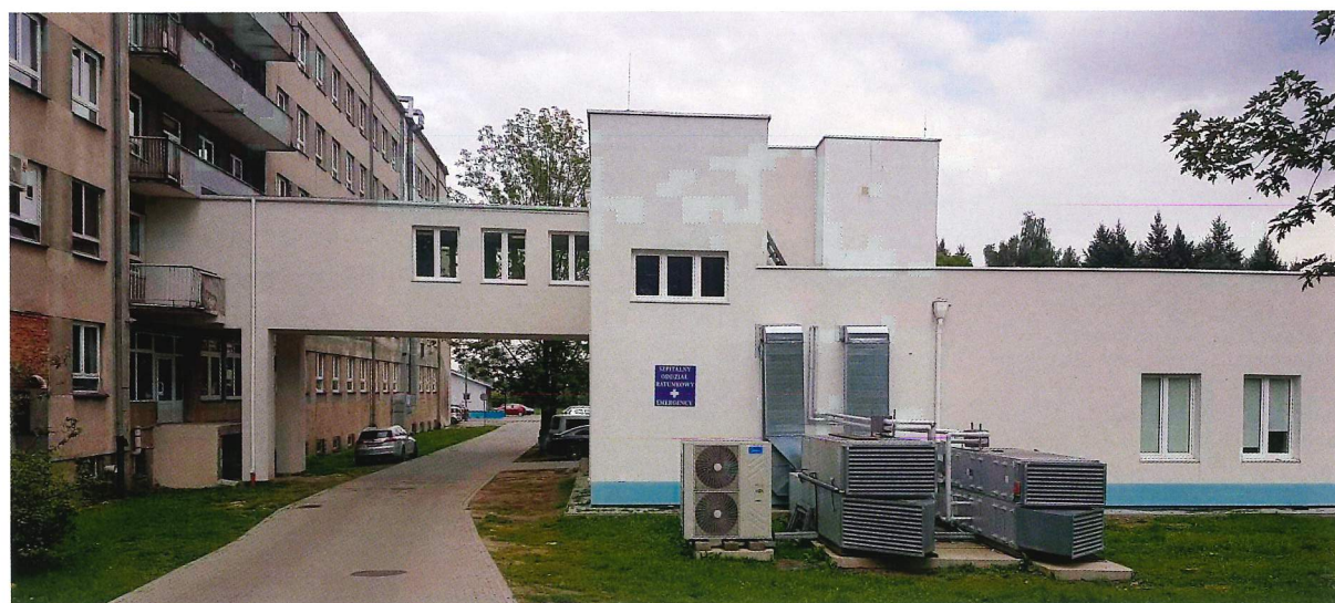
Fot. 3. Widok na łącznik i budynek SOR od zachodu
