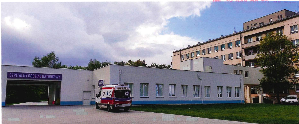
Fot. 4. Wejście główne na SOR oraz podjazd dla karetek w widoku od wschodu.
