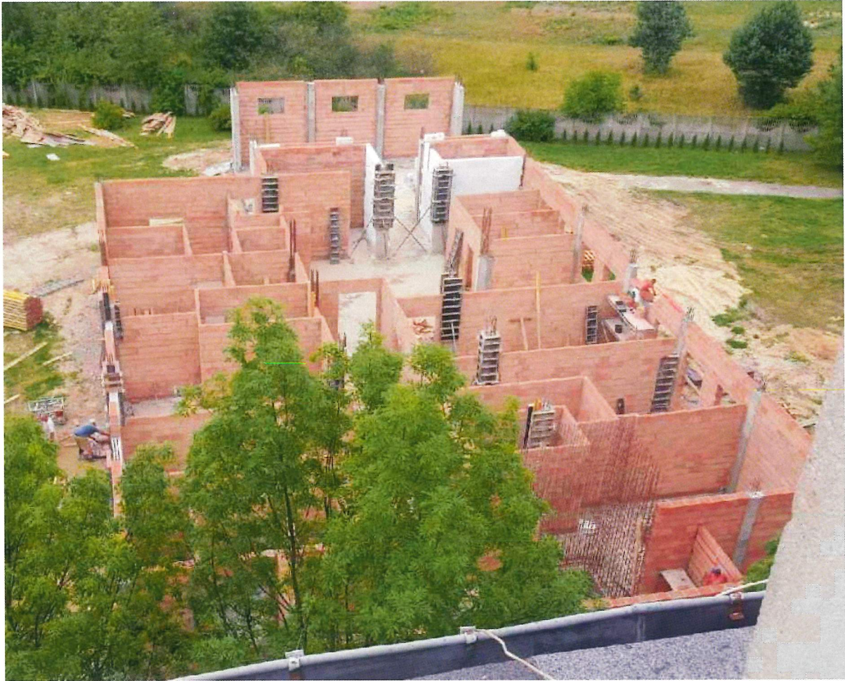
Fot. 10. Zdjęcie archiwalne budynku SOR w trakcie realizacji. Widok z okna budynku głównego szpitala.
